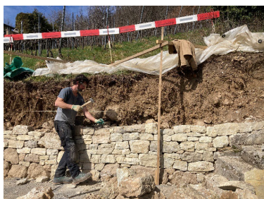
Bildlegende: Sanierung einer Stützmauer zwischen zwei Rebbergspartellen in der Flur «Les Blanchardes» von La Neuveville (Foto @ Naturpark Chasseral).
