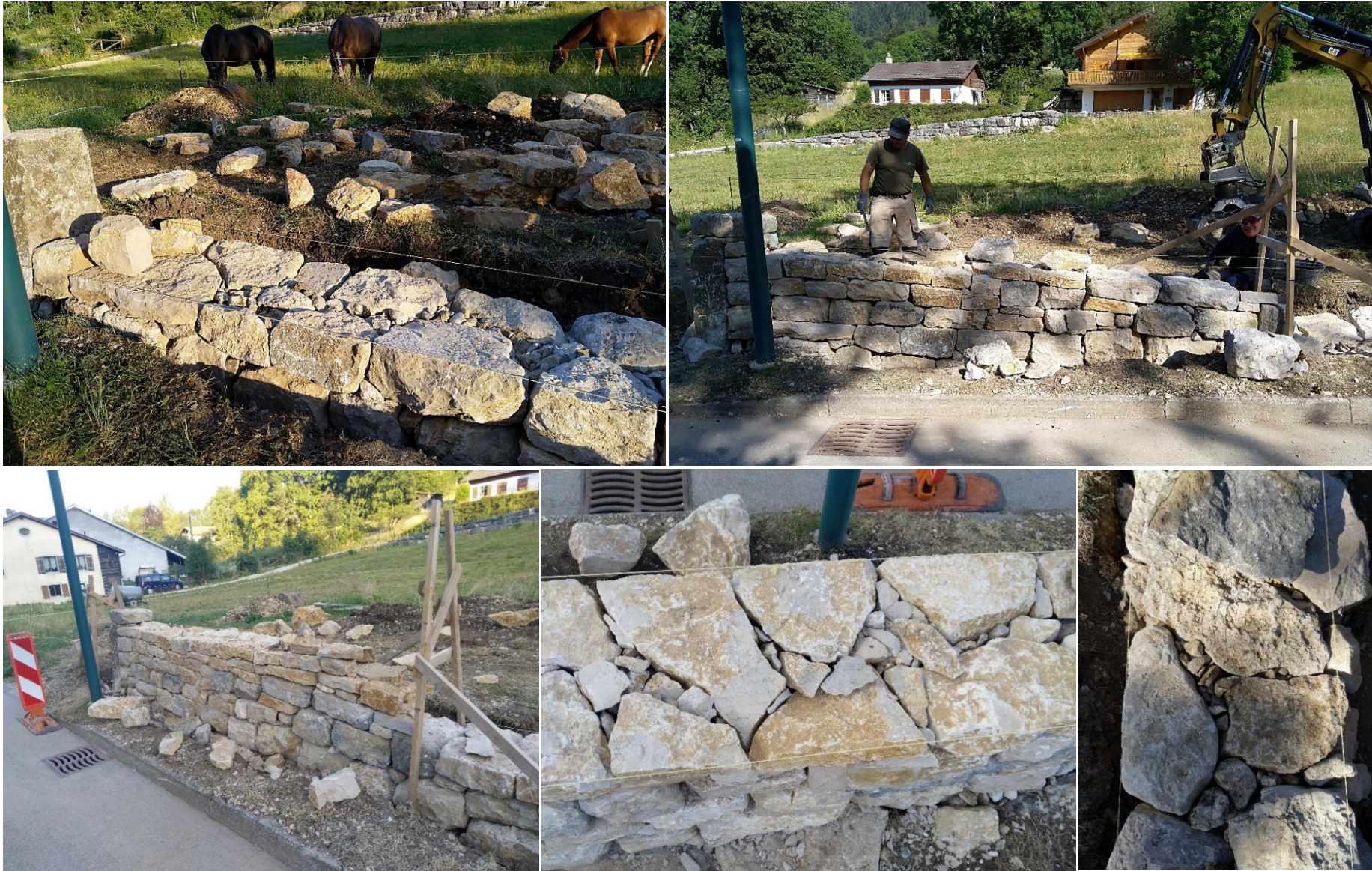
Figure 9 : étapes de la construction du mur.
