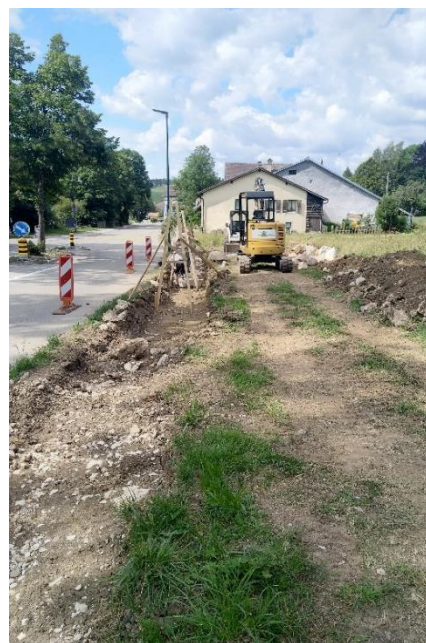
Figure 7 : Préparation de la fondation, le 12.07.2019
